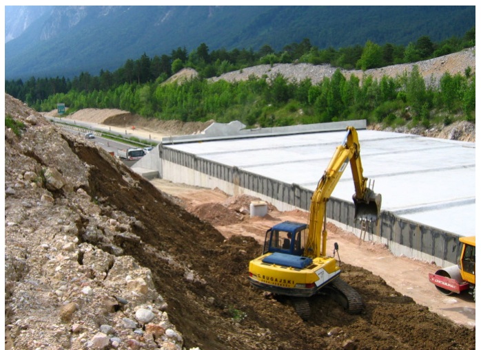
Die Bärenbrücke über die A2 zwischen Arnoldstein und Villach wird diesen Sommer fertiggestellt. Eine große Barriere für die Wanderung der Braunbären wird somit durchbrochen. (Foto: WWF-A/N. Gerstl)
