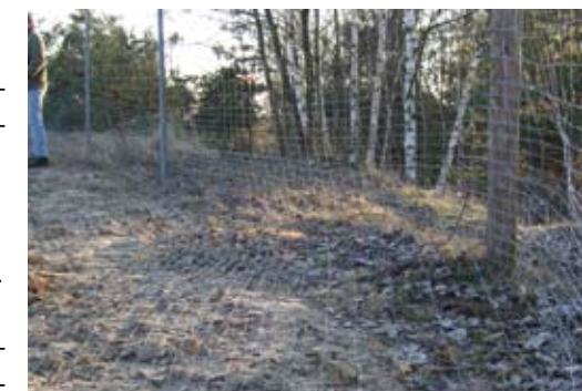
Unterwühlschutz mit Knotengeflecht am Boden
