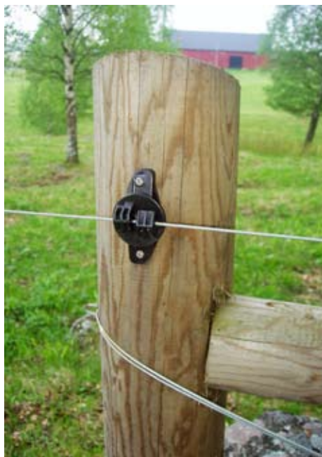
Hållbara isolatorer skruvas med gipsskruv.
